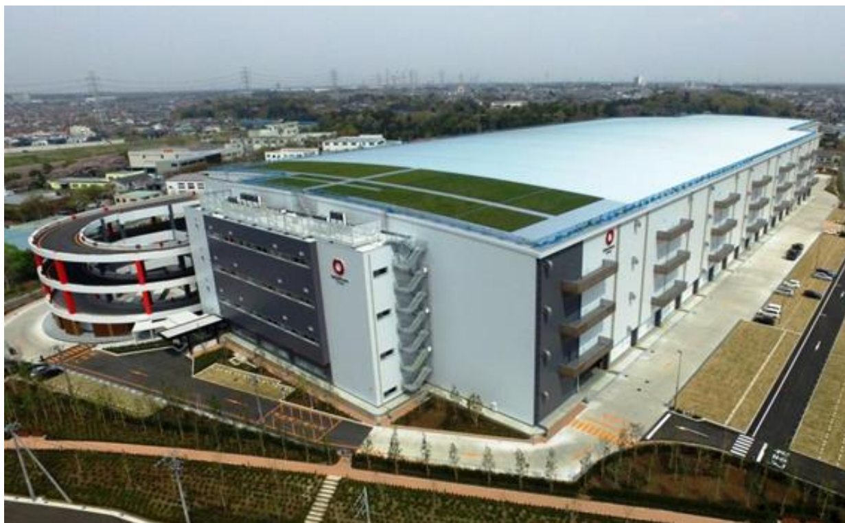
「D P L 流山 I」施設全景（提供：センコー㈱）
